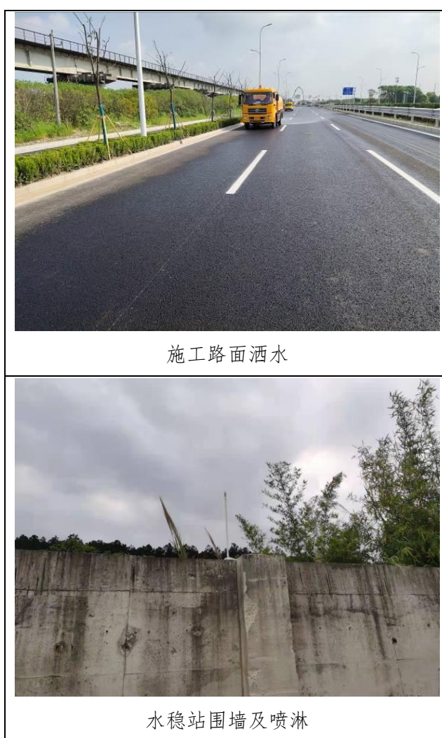
图 8.1-1 施工过程中扬尘控制
