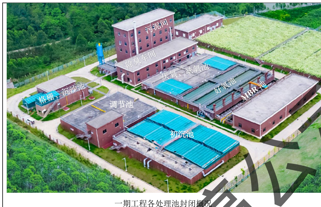
图 3.5-1 现有工程各处理池封闭照片
