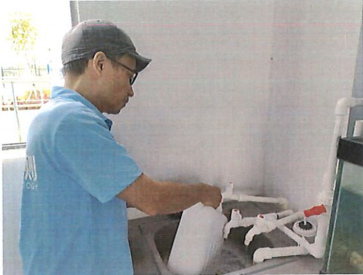
第三水厂出厂水采样口
