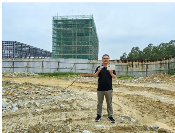
西南面（广东托肯新材料科技有限公司）
