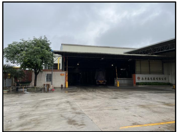
南面-鹤山市永丰泰包装有限公司（旧厂）
