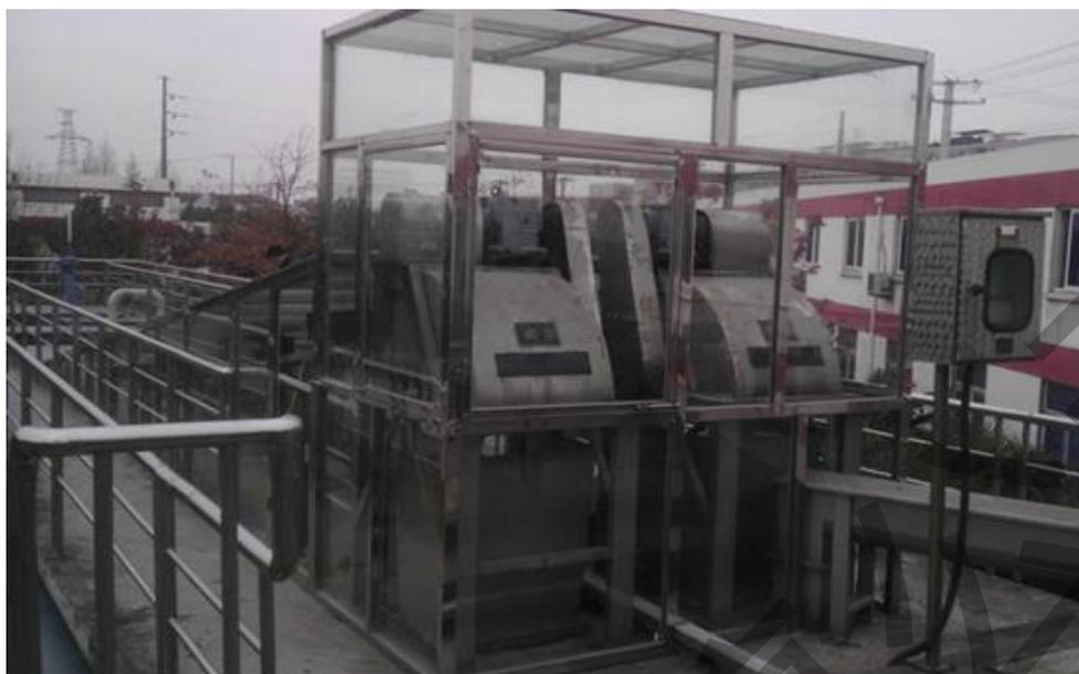
图 4.4-7 PC 耐力板+不锈钢方管骨架罩
