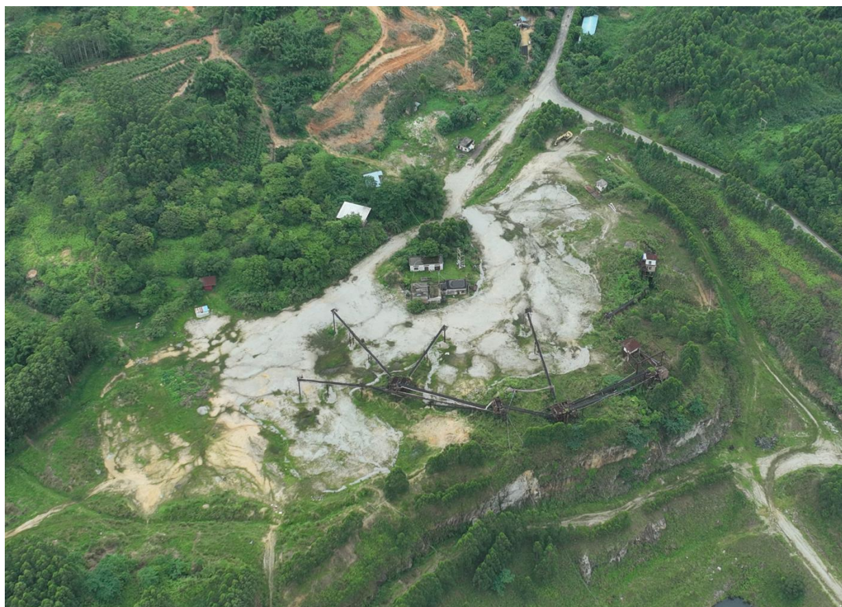
图 1-10 破碎站 1 现状 (2024.05, 镜向 NW)
