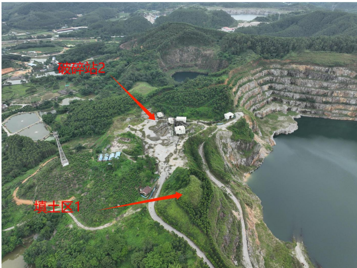
图 1-11 破碎站 2 及堆土区 1 现状 (2024.05, 镜向 SE)
