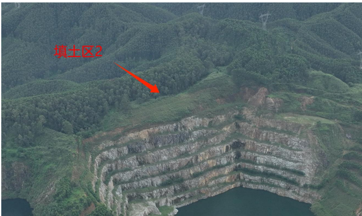
图 1-12 堆土区 2 现状 (2024.05, 镜向 S)
