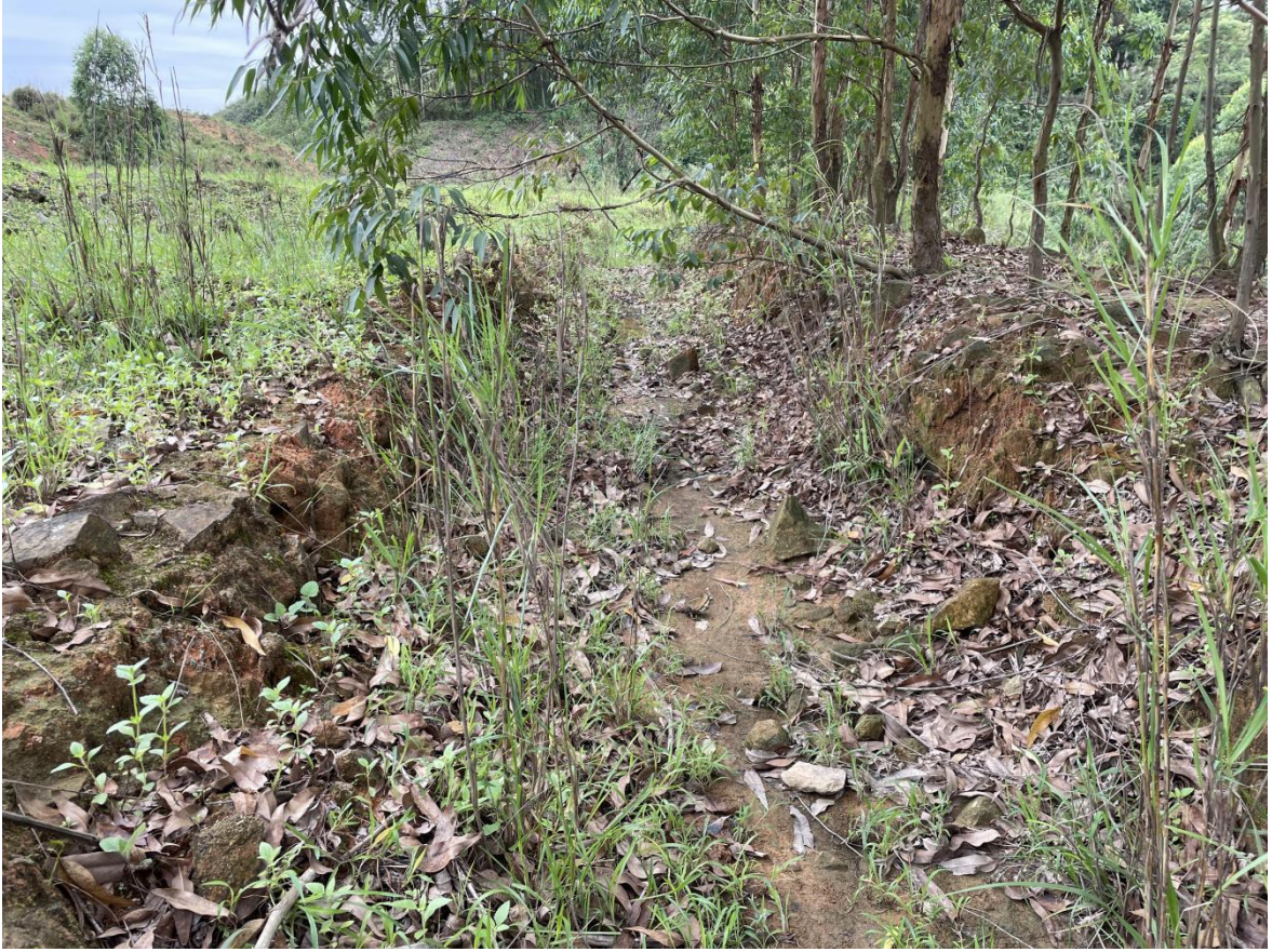
照片 8 排土场 2 平台排水沟 (2024.05.29, 镜像 SE)
