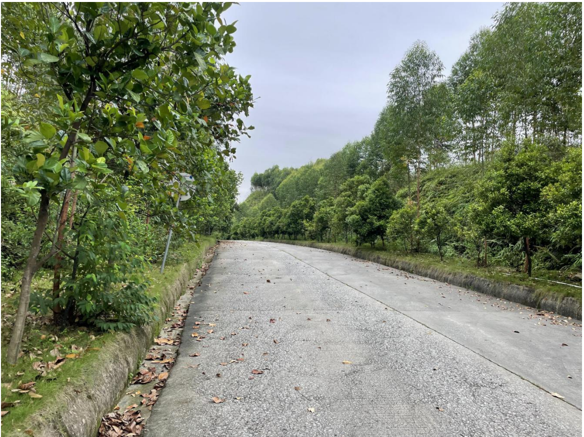
照片 9 综合服务区至破碎站 1 道路现状 (2024.05.29, 镜像 NW)
