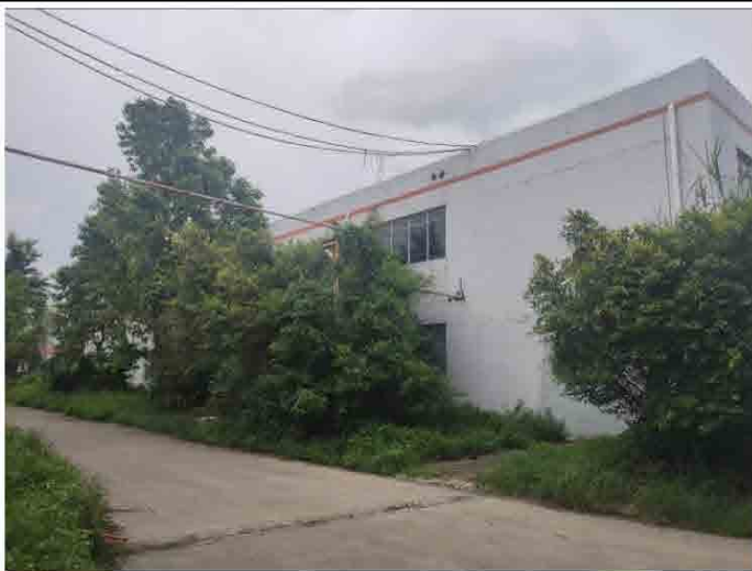
项目东面：广东东旭化学工业制造有限公司丙类车间（待拆）
