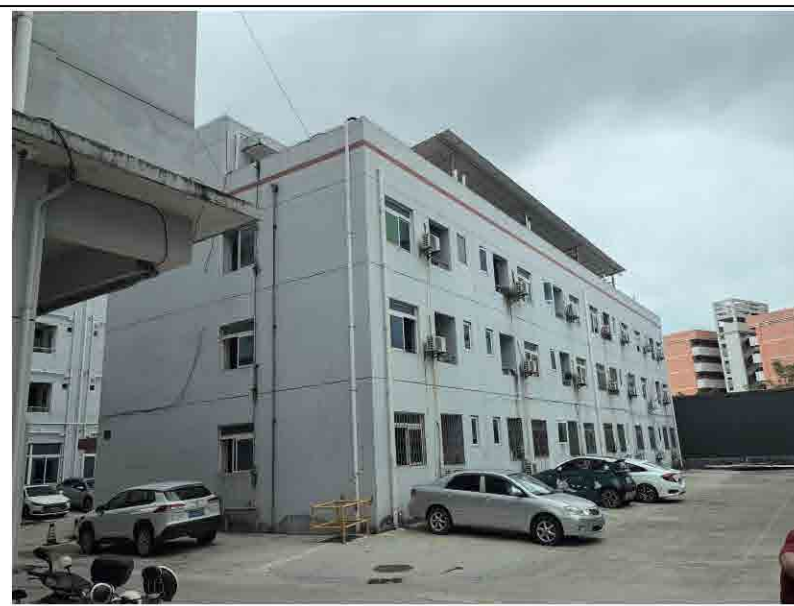
项目南面：广东东旭化学工业制造有限公司宿舍楼
