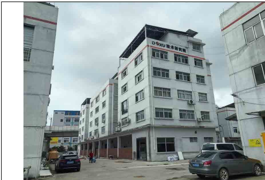
项目南面：广东东旭化学工业制造有限公司研发楼
